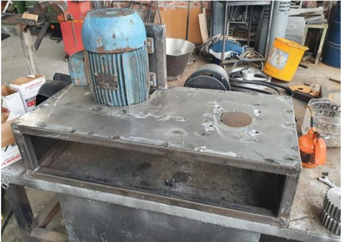
Figura 79. Forrado de la estructura metálica.
