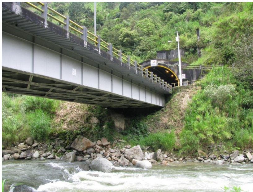
Fotografía 1: Puente de Estructura mixto Fuente: EPMMOP-Q
