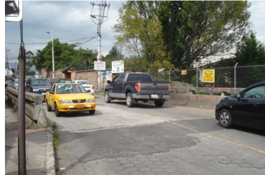
Fotografía3: Vista de la calzada.
