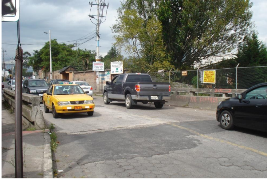
Fotografía 1: Tráfico vehicular sobre el Puente existente.
