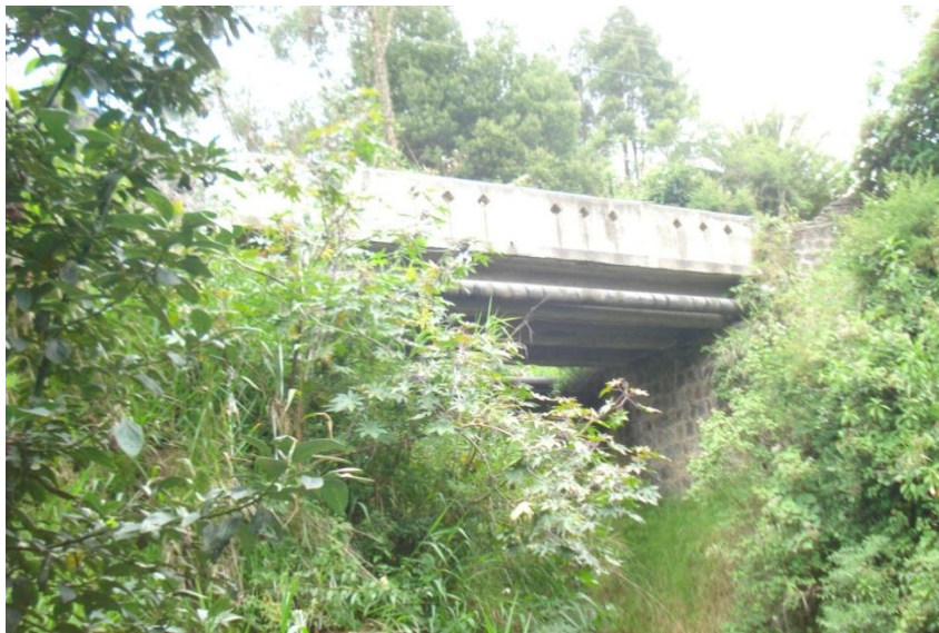
Fotografía 2: Vista de la infraestructura.
