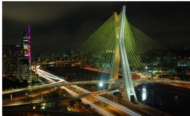
Figura 2: Puente atirantado de Sao Paulo Octavio Farías Portal: skyscrapercity.
