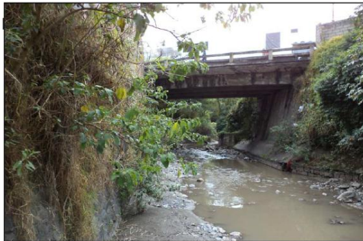
Fotografía 2: Vista del puente existente.
