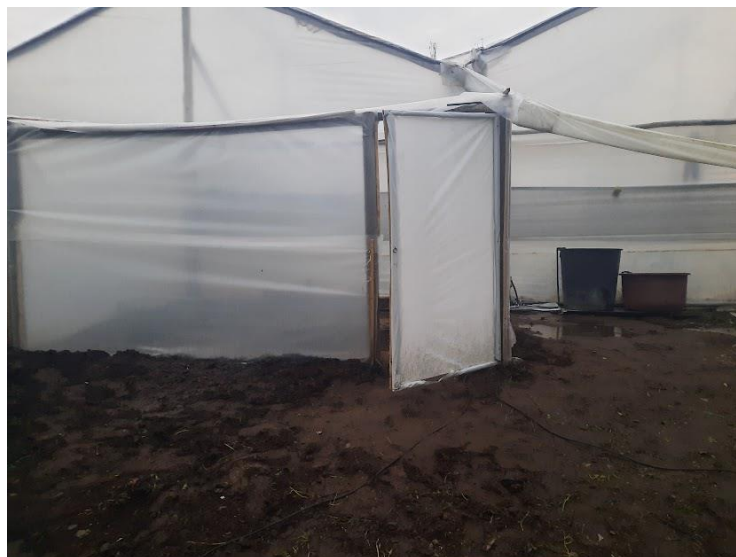
Figura 33: La construcción del invernadero
