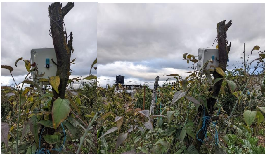
Figura 37 Módulo de detección de temperatura, humedad ambiental y radiación solar
