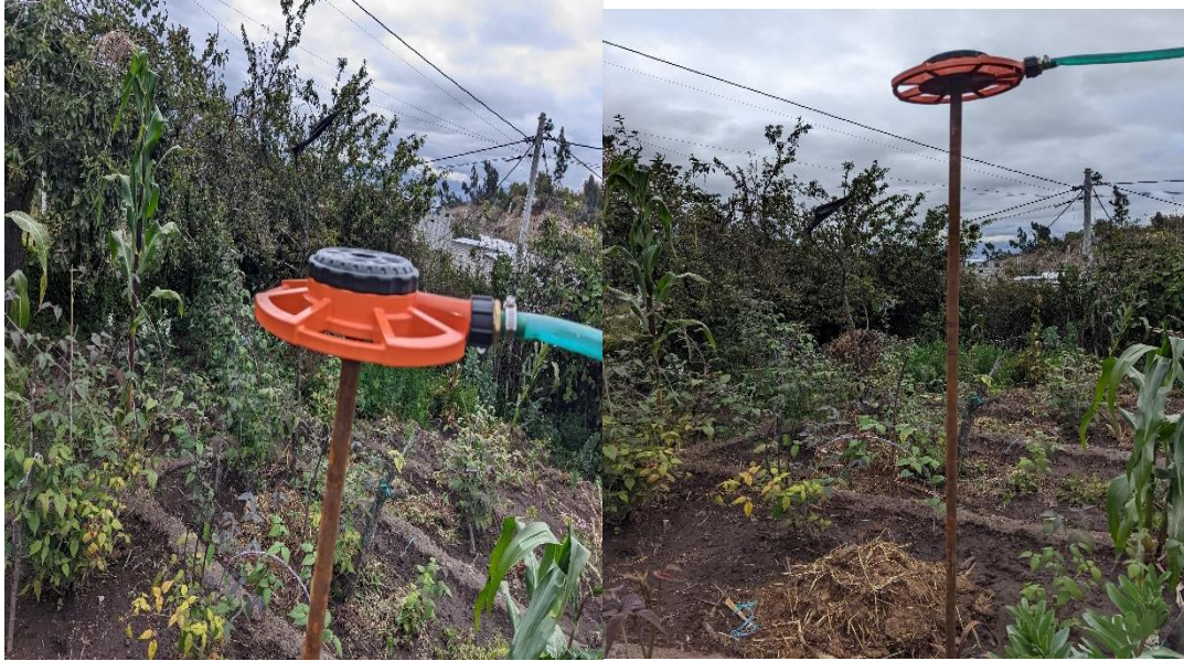
Figura 38 Instalación de aspersor ASP-8
