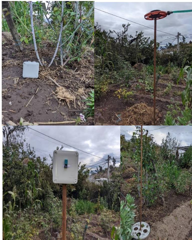
Figura 42 Sistema ubicado en el terreno
