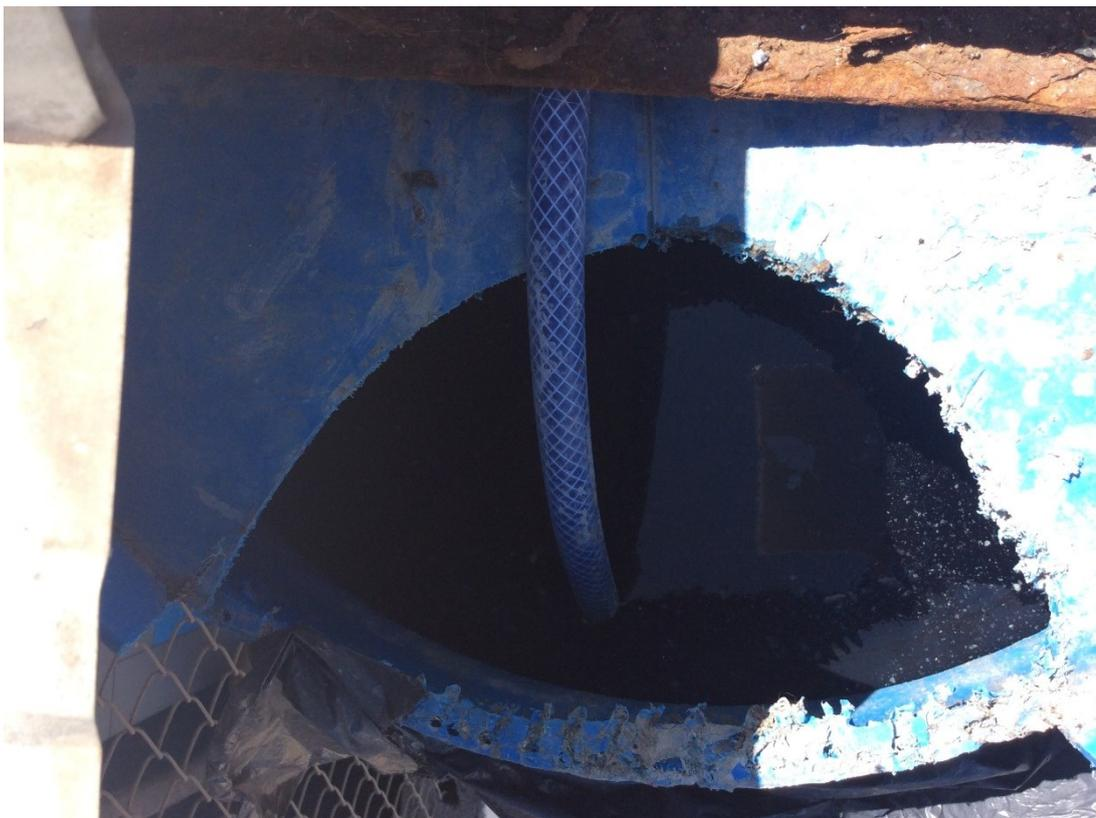
Fotografía 12: Tanque y bomba sumergible para el llenado del tanque de abastecimiento.
