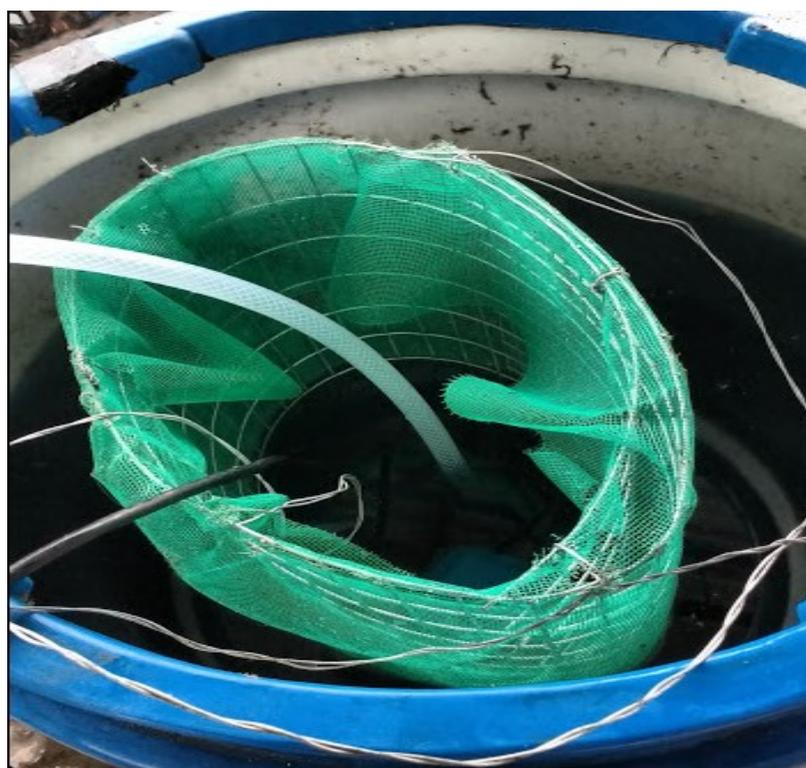
Fotografía 13: Llenado del tanque de abastecimiento mediante bomba sumergible.
