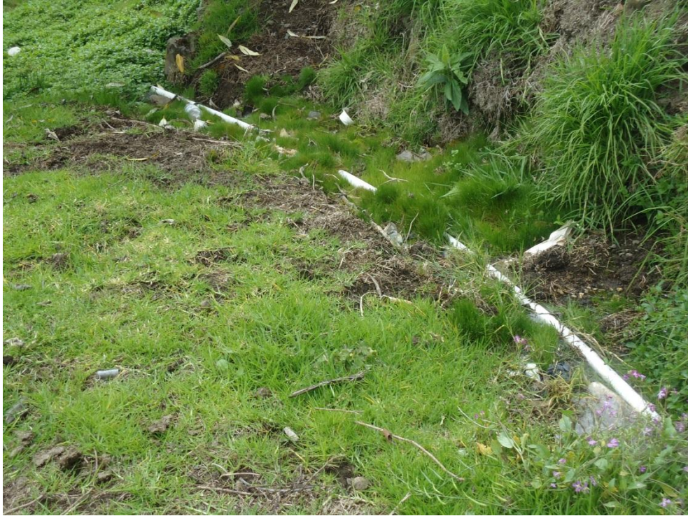
Grafica 9. Tubería de Conducción para Shuyo Chico
