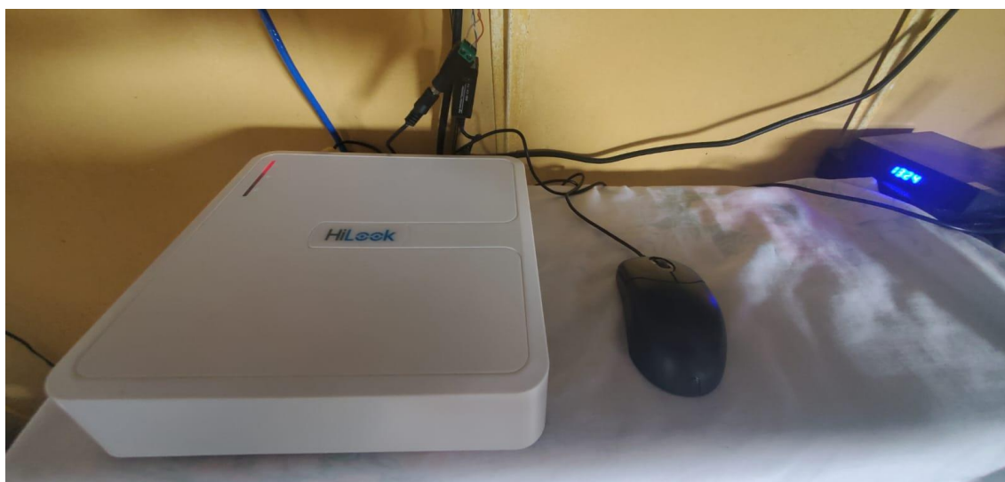
Figura E4. Instalación y conexión del DVR con las cámaras
