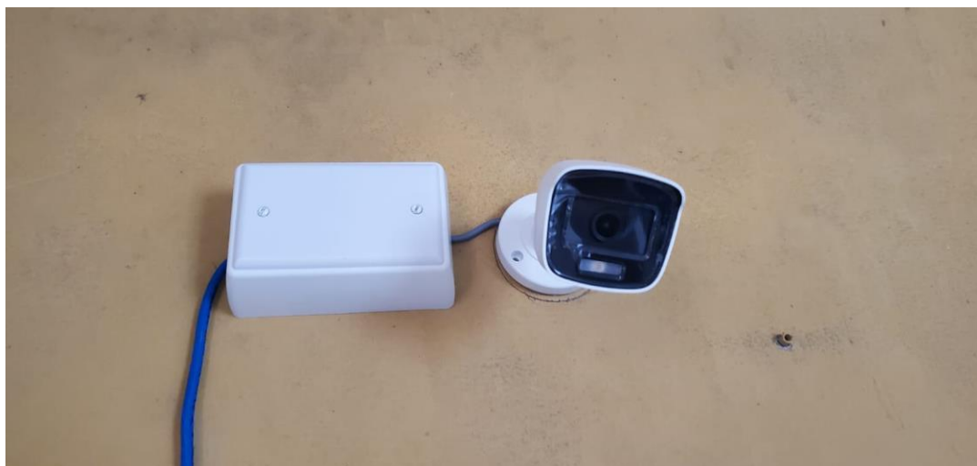
Figura E1. Instalación de cámara tipo tubo en la sala
