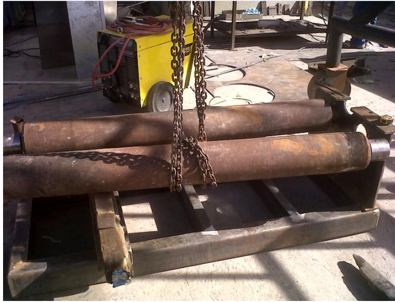
IMAGEN 6.7.4. Montaje de los rodillos inferiores
