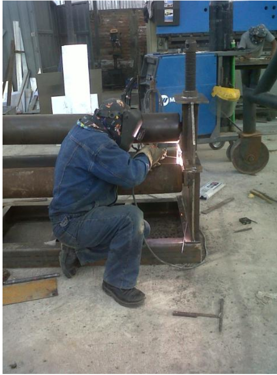
IMAGEN 6.7.6. Montaje del sistema de regulación.
