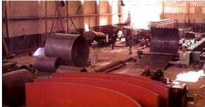
Fig. 2.5 Fabricación de Cilindros para Tanques
