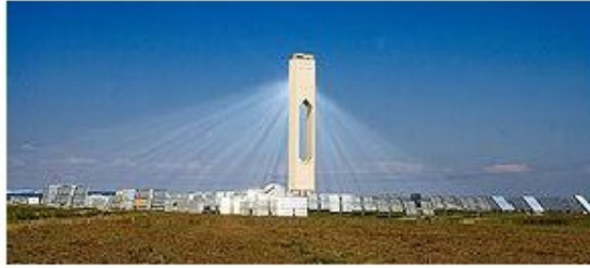
Gráfico 32: La central termosolar PS10 de 11MW funcionando en Sevilla, España.
