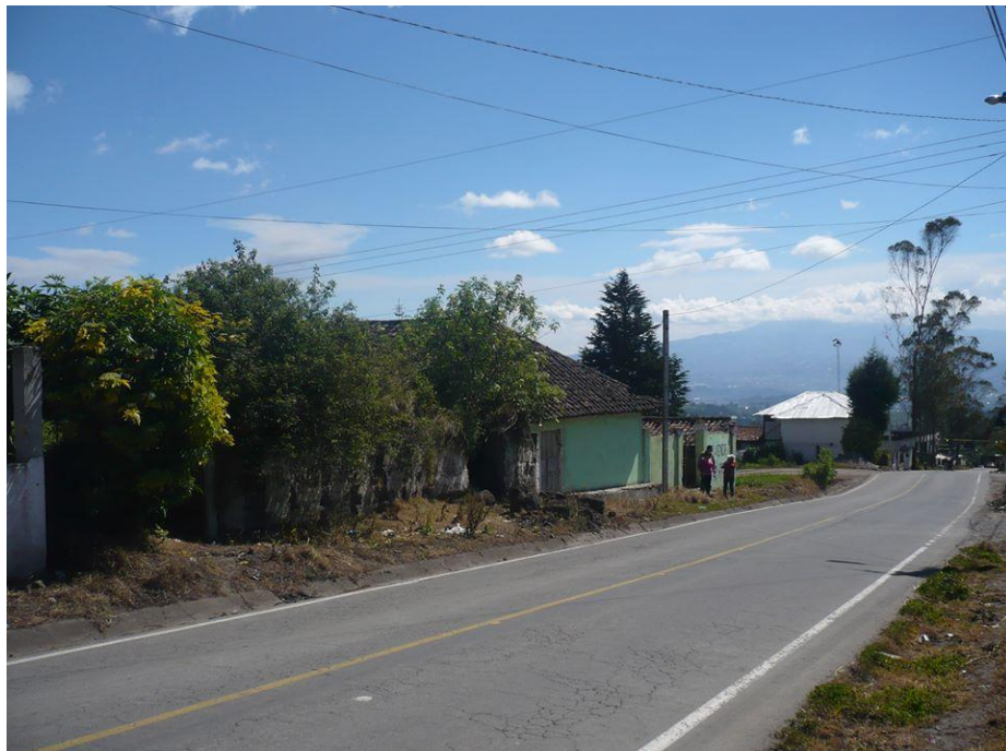
Gráfico # 38 Edificación actual
