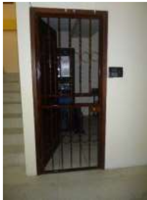
Fig. 20 Puerta de Acceso al Cuarto de Servidores
