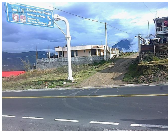
Llegada e intersección con la vía principal interprovincial Ambato-Pelileo-Baños
