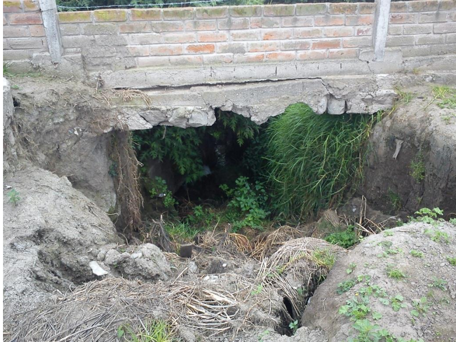
Imagen D.1. Planta de tratamiento Puerto Arturo previo mantenimiento de infraestructura de cerramiento hacia la quebrada.
