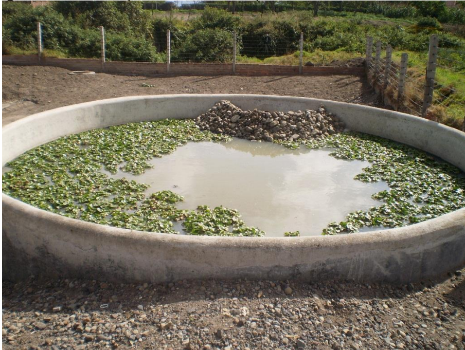
Imagen D.8. Filtro de piedra ascendente planta de tratamiento Puerto Arturo
