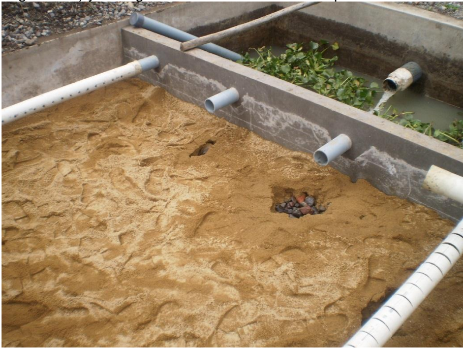
Imagen D.14. Colocación de piedra, arena de cuarzo, tubos PVC (flautas para oxigenación) y lechuguín en el filtro modificado de piedra descendente
