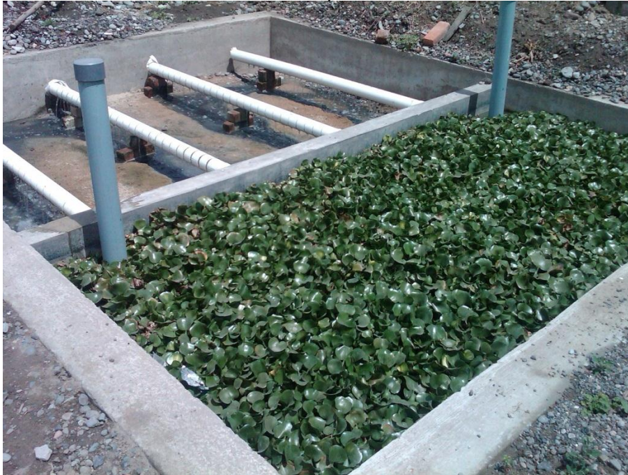
Imagen D.15. Implementación de lechuguín, flautas para oxigenación, arena de cuarzo y filtro de piedra
