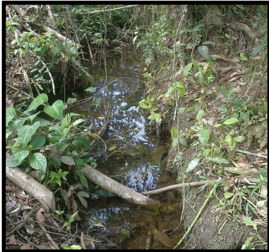
Riachuelo existente Km 0+980- Vía a Juan de Velasco
