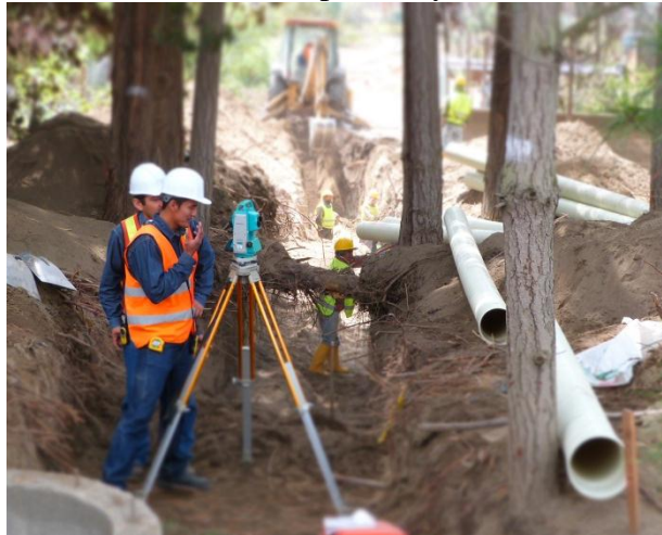
Gráfico N° 14: Replanteo y Nivelación.
