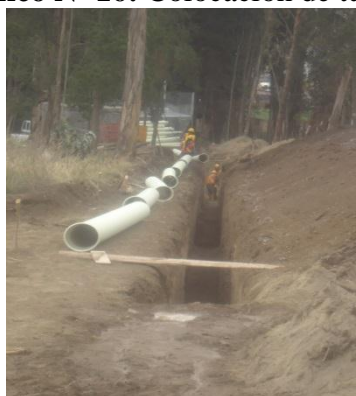
Gráfico N° 16: Colocación de tubería
