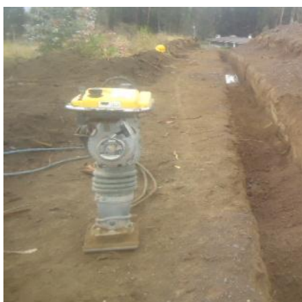
Gráfico N° 20: Relleno y compactación
