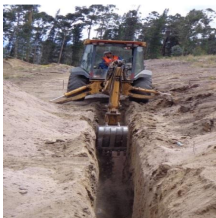
Gráfico N° 15: Excavación de zanjas
