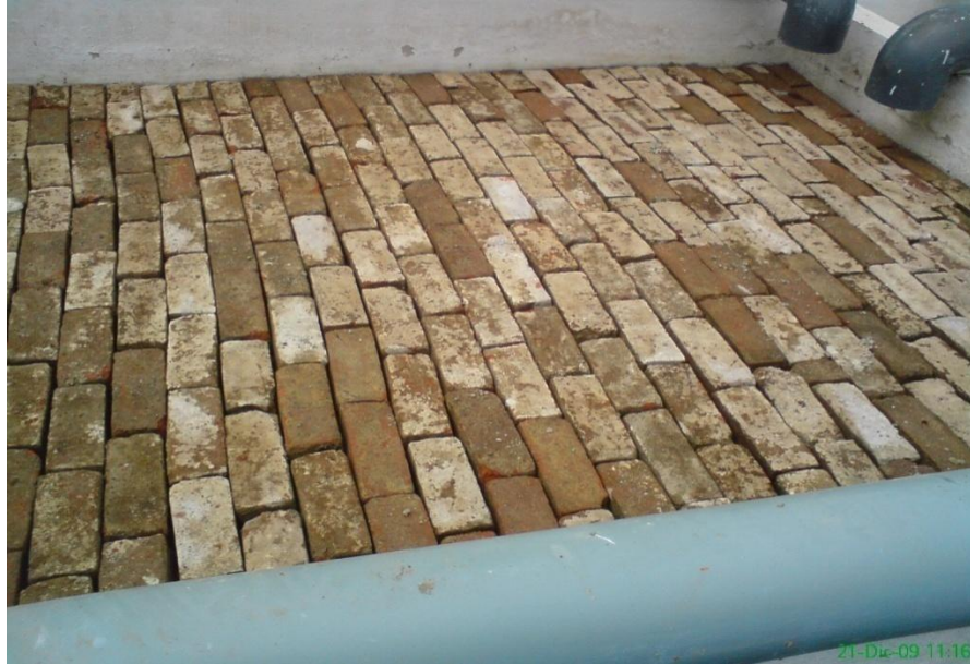
Imagen 9. Lecho de secado de lodos
