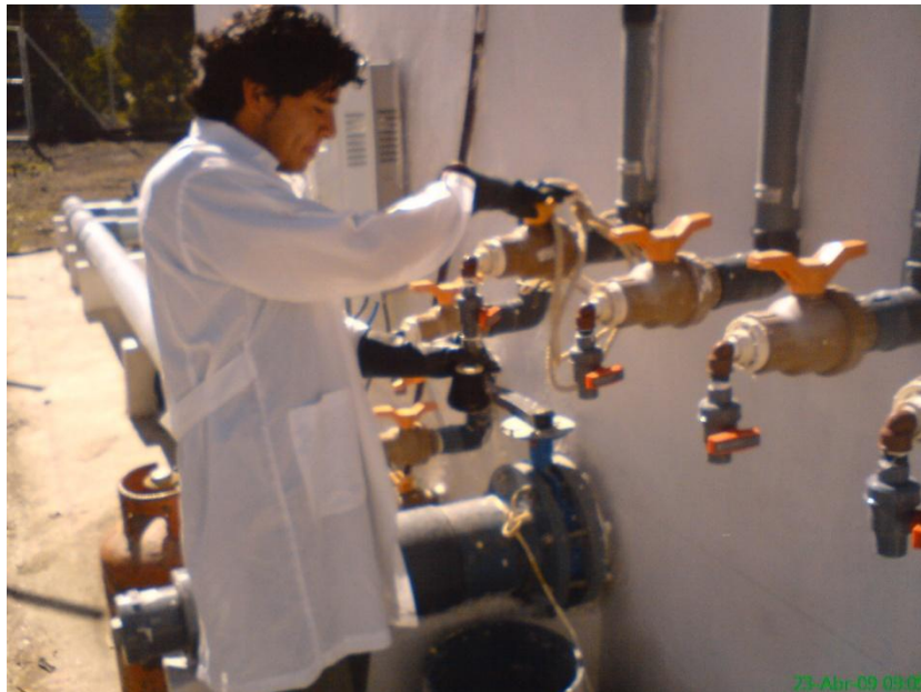
Imagen 12. Realización del muestreo de lixiviado a diferentes alturas del UASB
