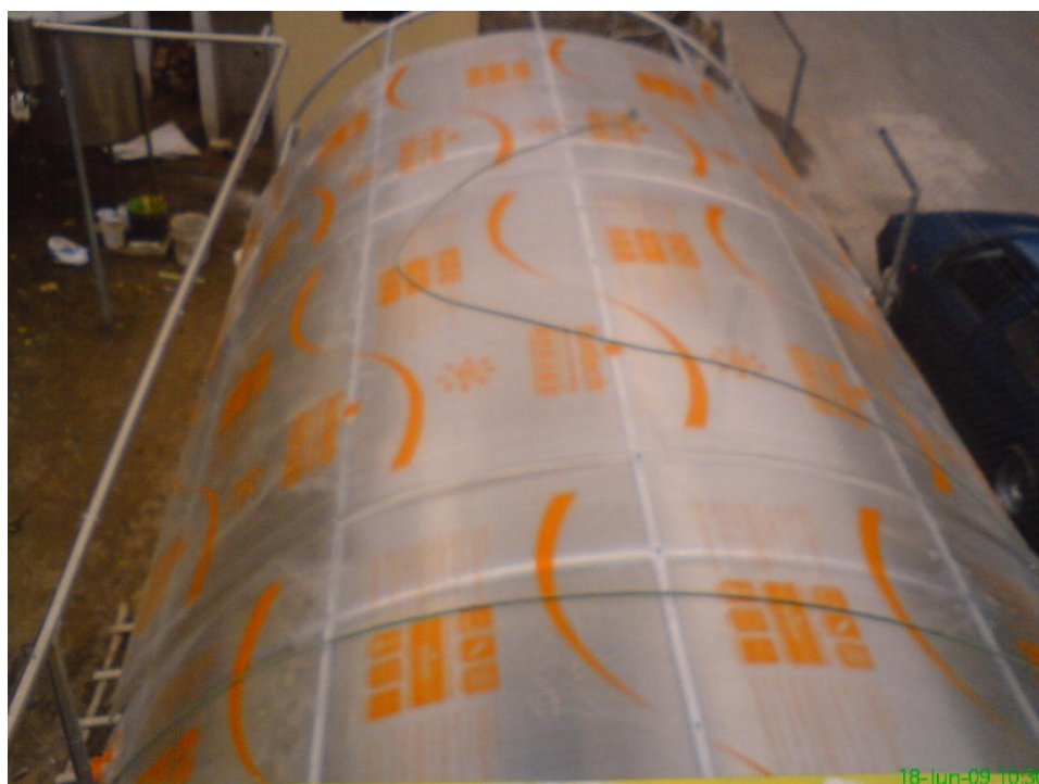
Imagen 14. Cubierta instalada actualmente
