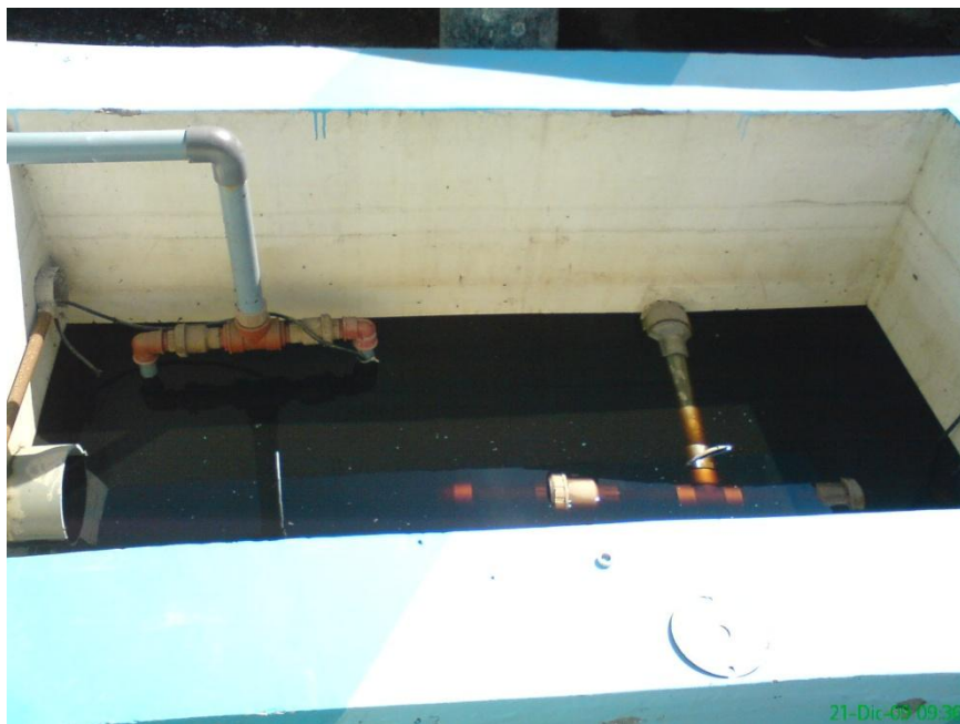
Imagen 6. Pozo de bombas 2
