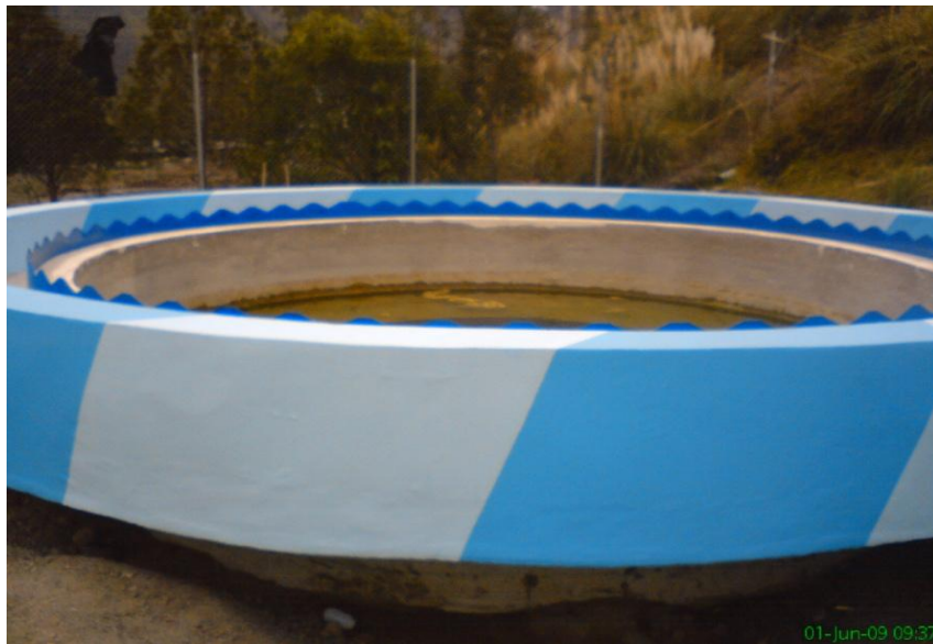
Imagen 8. Tanque Clarificador
