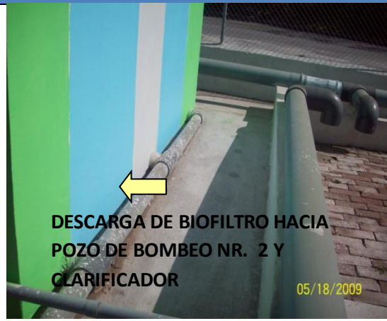
Tuberías de descarga
