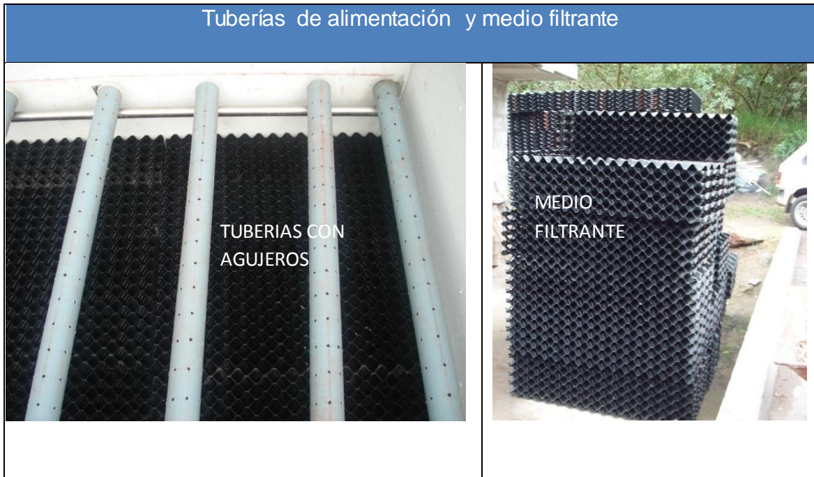
Imagen 5. Biofiltro Percolador (BFP)
