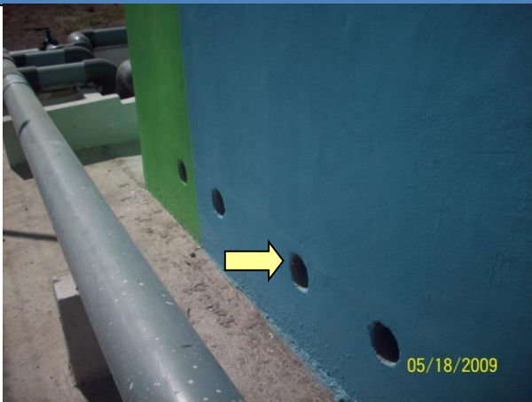
Agujeros de ventilación Biofiltro
