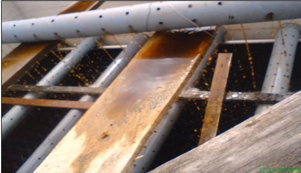
Imágenes 23 – 24. Trabajo realizado para la recirculación del efluente del camal en el biofiltro.
