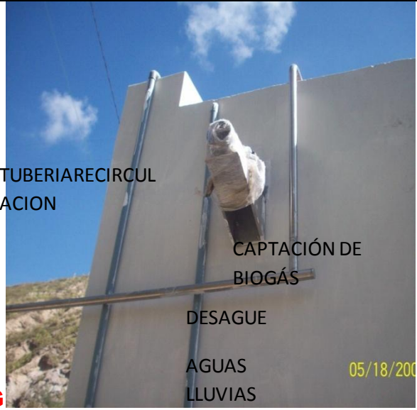
Tuberías de descarga
