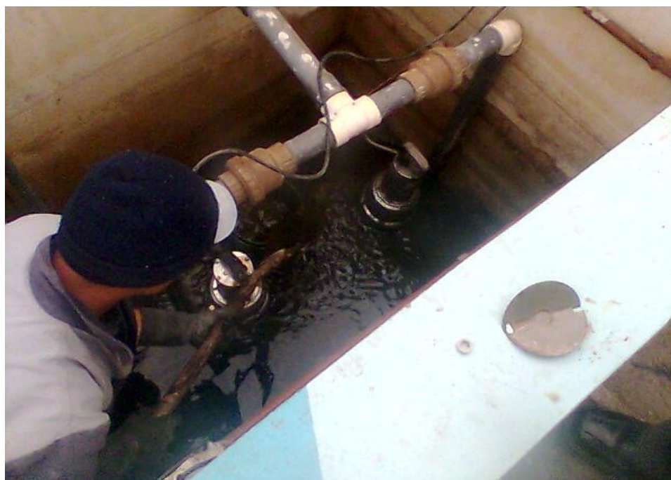
Figura 1: Limpieza de lodos en el pozo de bombas 2.
