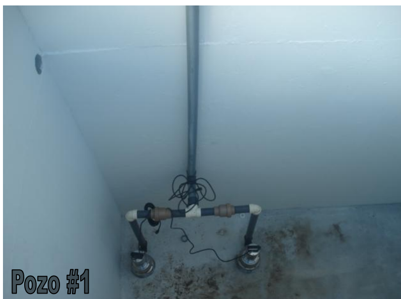
Imagen 2. Pozo de bombas #1
