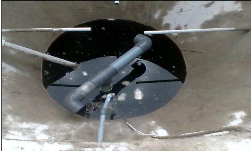
Imagen 32. Adaptación realizada en el clarificador para incrementar turbulencia.
