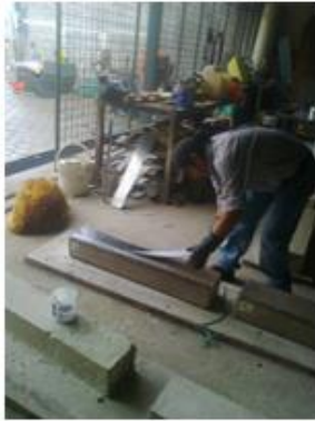
COLOCACIÓN DEL REFORZAMIENTO CFRP, PROCESO DE FRAGUADO DE LA RESINA
