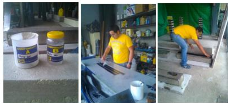
PREPARACIÓN DE LA RESINA, SATURACIÓN DE A FIBRA Y COLOCACIÓN DEL REFORZAMIENTO CFRP
