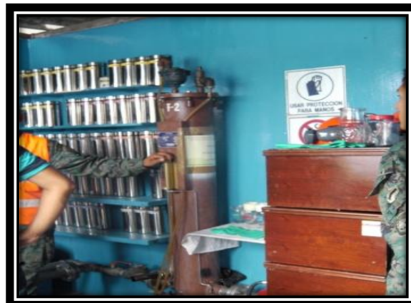
Foto N°3: AREA DE MUESTRAS DE COMBUSTIBLE Y FILTRO
