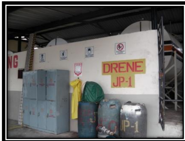
Foto N°2: AREA DE DRENE
