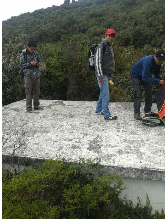
Foto 3: Toma de medidas de las instalaciones existentes
