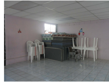
Fotografía N°: 22 SALA DE TERAPIAS
