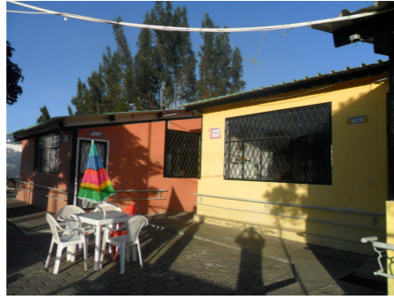
Fotografía N°: 27 PATIO
