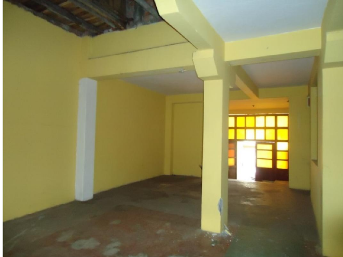
Fotografía N°- 8 Acceso al auditorio y espacio vacío Fuente: Toma fotográfica por el investigador
