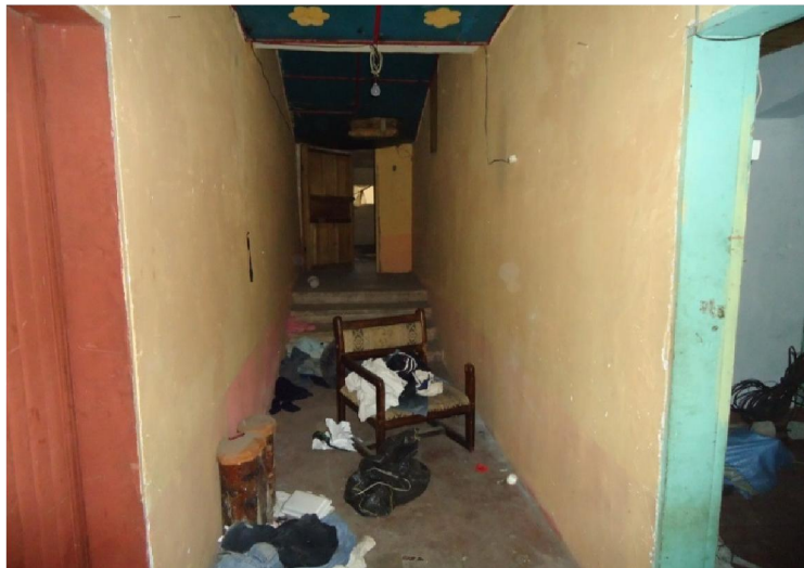
Fotografía N°- 14 Acceso al área de palco Fuente: Toma fotográfica por el investigador
