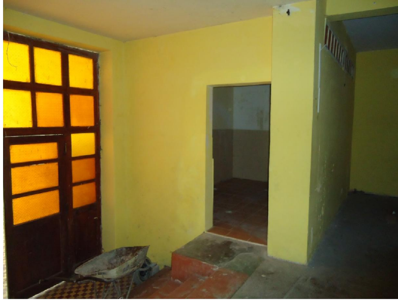
Fotografía N°- 6 Acceso al auditorio y cuarto vacío Fuente: Toma fotográfica por el investigador
