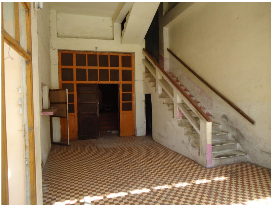
Fotografía N°- 5 Acceso al auditorio y a la segunda planta Fuente: Toma fotográfica por el investigador
