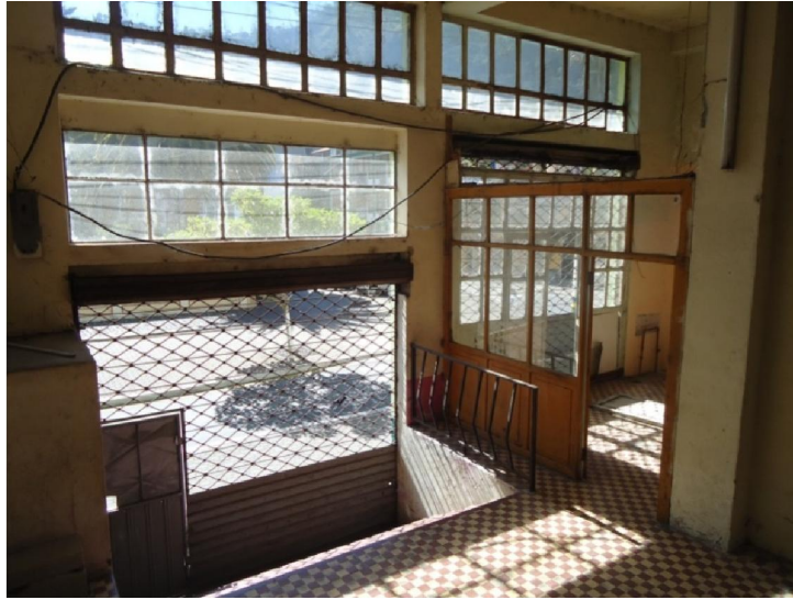
Fotografía N°- 2 Acceso y espacio vacío Fuente: Toma fotográfica por el investigador
