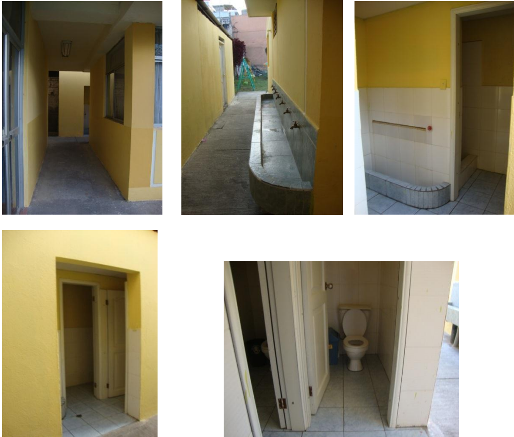
Fotografía N° 9: Baños infantiles Fuente: Toma fotográfica por la Investigadora
