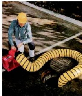
Ventilación general de un pozo de registro
