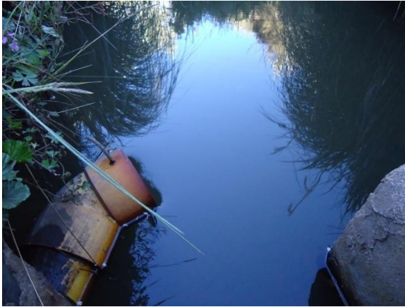
13. Zona de captación del agua
