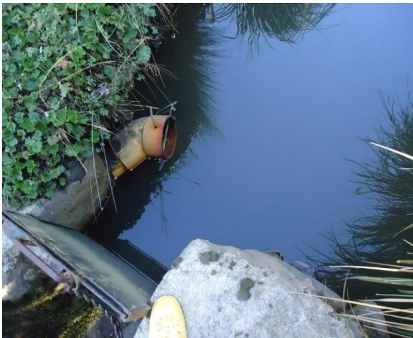
15. Compuerta de desagüe
