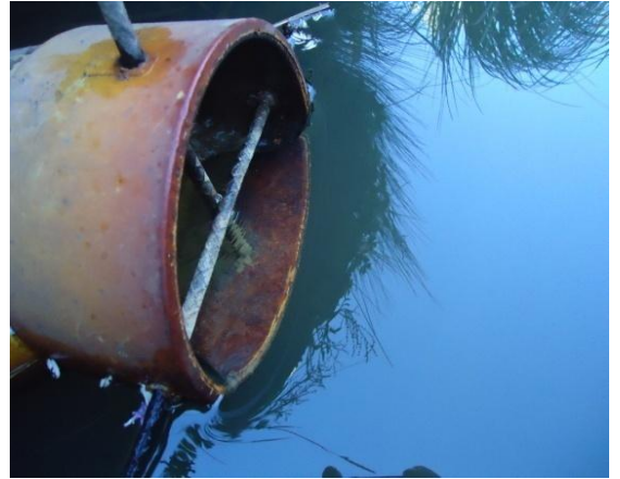
14. Varillas de protección
