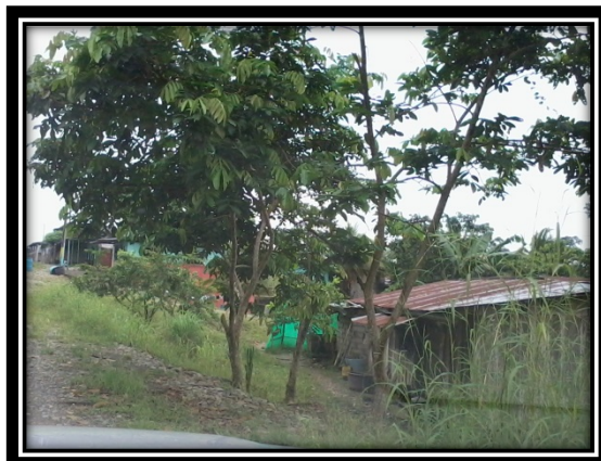
CASAS MAS BAJAS QUE LA RED DE ALCANTARILLADO
