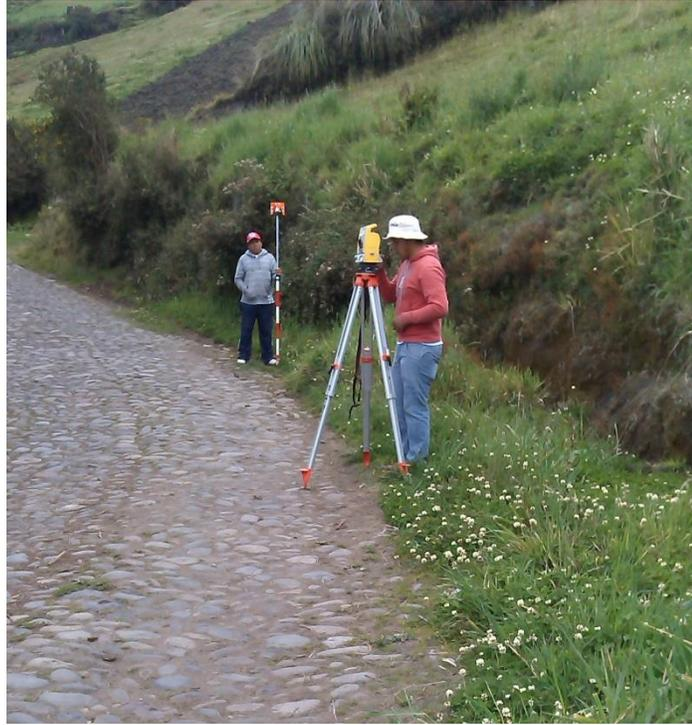
**Fotografía 7.- Replanteo de la línea de conducción del proyecto**
