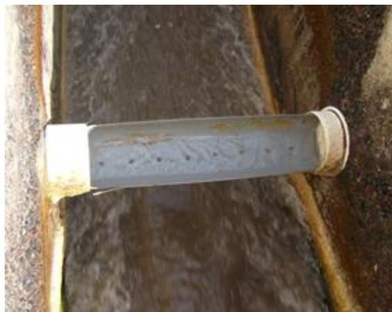
**Ilustración 22:** Chorro continuo para la inyección de Policloruro de aluminio
