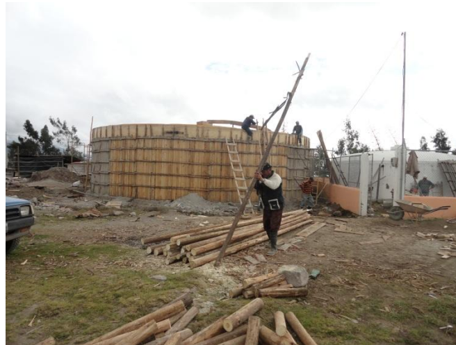
Figura 54 Tanque en Construcción ATANSE
