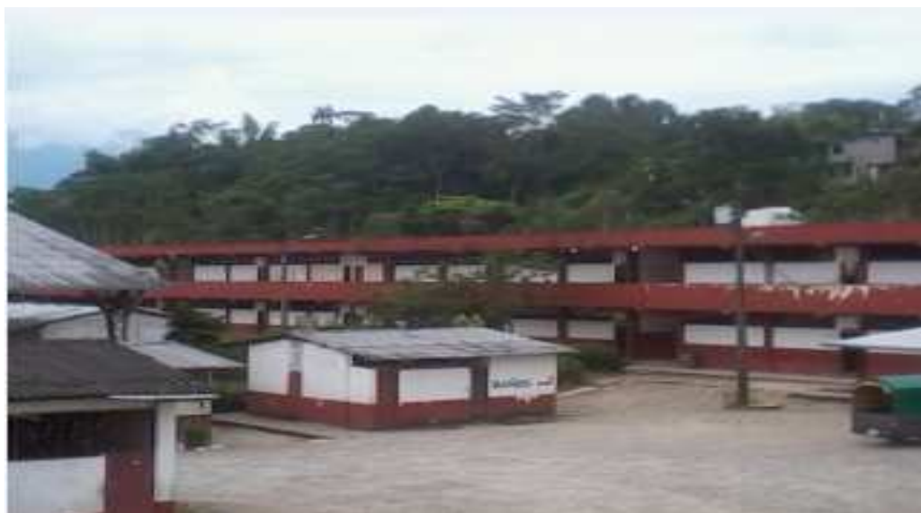
BLOQUE DE AULAS
