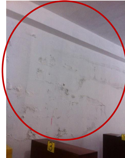
Gráfico: A.1 Fotografía de Pared húmeda del Laboratorio Tics(Elaborado por: Investigador)
