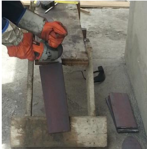
Ilustración 55.- Construcción electrodos de hierro Fuente: Evidencia proceso de construcción
