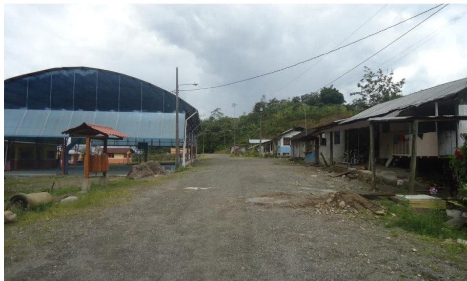
Grafico N° 4.15: Condiciones de la vía Tramo: Km 2+000 - Km 2+250.
