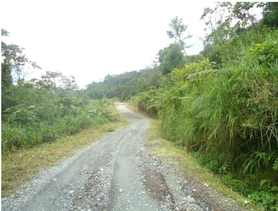
Grafico N° 4.13: Condiciones de la vía Tramo: Km 1+000 - Km 1+500.
