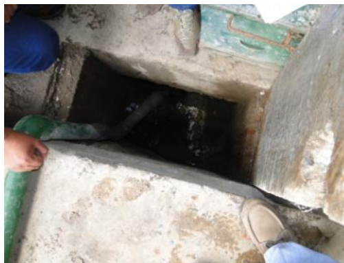
FIGURA 4 - 103: Ampliación de caja de revisión - Proyecto PTAR
