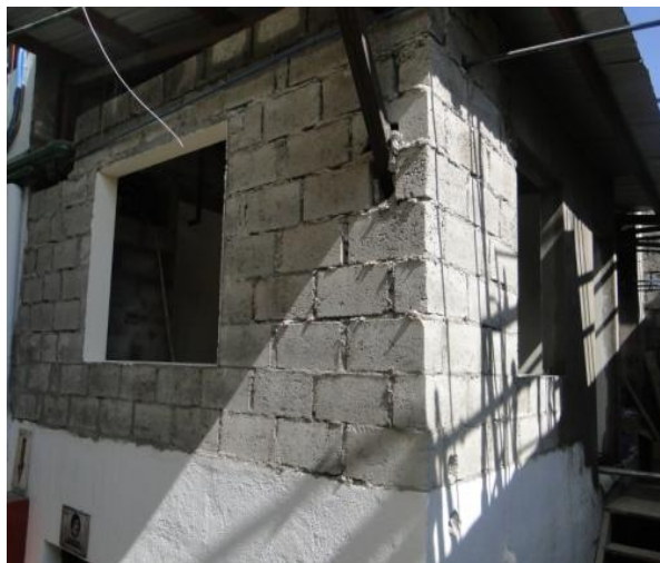
FIGURA 4 - 61: Construcción de oficinas – Proyecto PTAR
