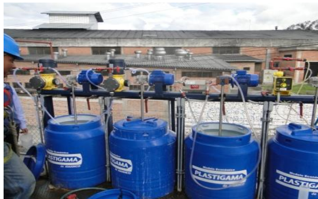
FIGURA 4 - 78: Instalación de Mangueras Dosificadoras- Proyecto PTAR
