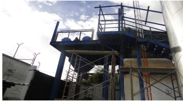
FIGURA 4 - 73: Aislamiento Eléctrico Pararrayos – Proyecto PTAR
