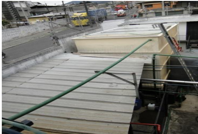
FIGURA 4 - 99: Desmantelamiento línea de agua - Proyecto PTAR
