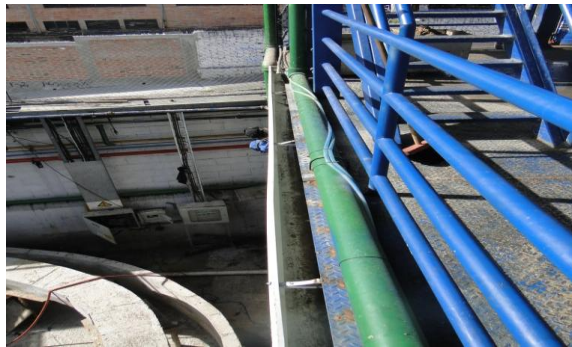
FIGURA 4 - 82: Cambio de tubería a 4 pulgadas - Proyecto PTAR
