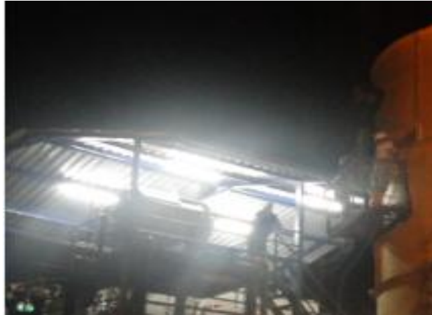
FIGURA 4 - 71: Nuevos Puntos de Luz – Proyecto PTAR
