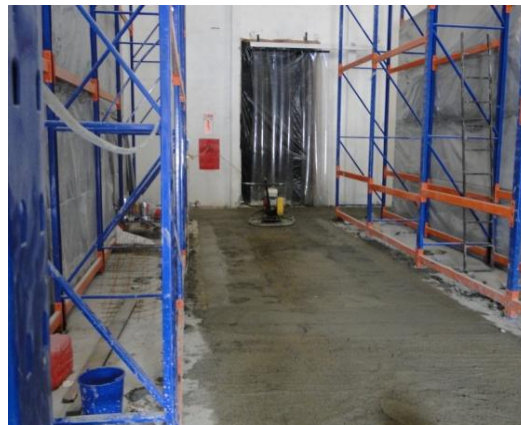
FIGURA 4 - 37: Trabajos realizados con retrasos – Restitución de Pisos Carcelén
