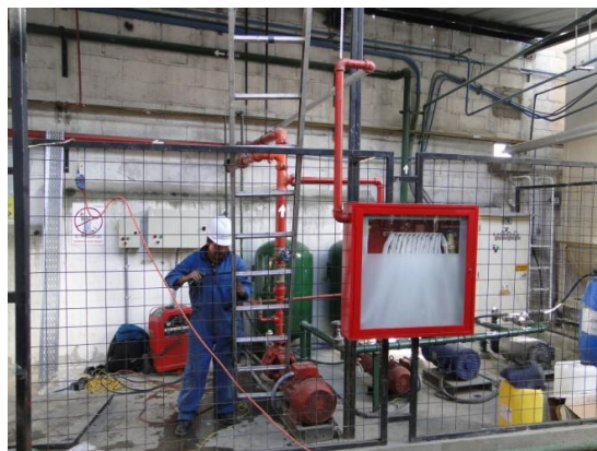
FIGURA 4 - 18: Instalación Nueva Gabinetes – Sistema contra incendios
