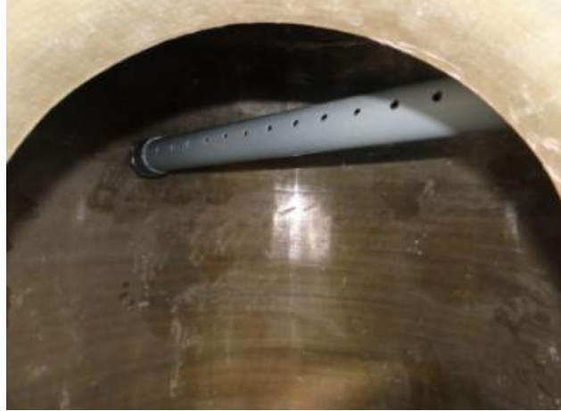
FIGURA 4 - 98: Sistema de Agitación de Aire - Proyecto PTAR
