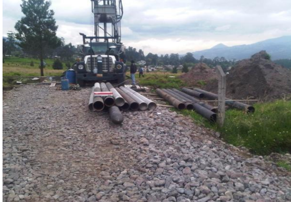
FIGURA 4 - 9: Adecuación de Pozos
