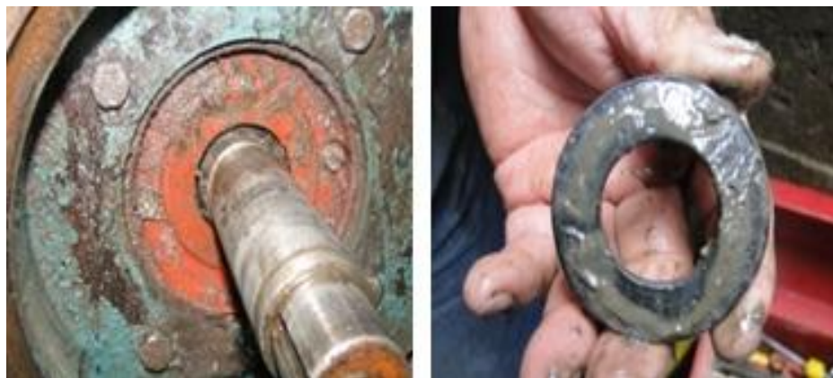
FIGURA 4 - 91: Cambios de Sellos Mecánicos - Proyecto PTAR
