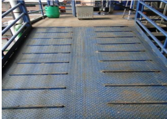
FIGURA 4 - 92: Instalación de Ángulos - Proyecto PTAR
