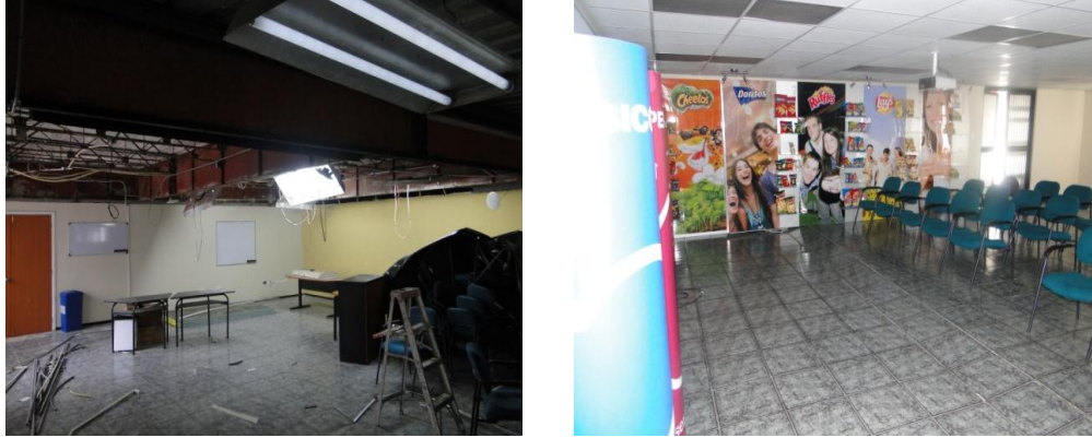
FIGURA 4 - 47: Trabajos oficinas Carcelén
