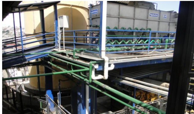
FIGURA 4 - 80: Instalación de tubería en líneas del CAF - Proyecto PTAR
