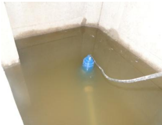
FIGURA 4 - 101: Montaje Bomba Sumergible - Proyecto PTAR
