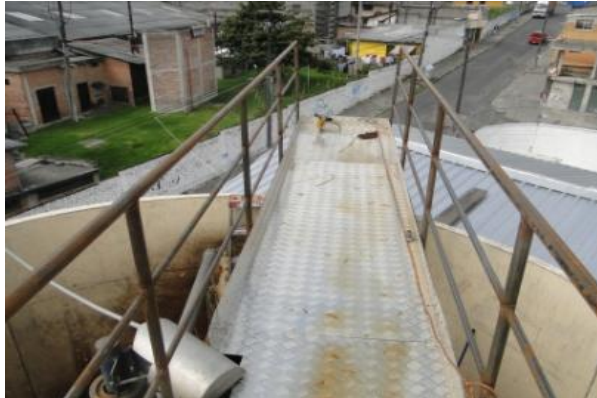
FIGURA 4 - 102: Instalación de estructura - Proyecto PTAR
