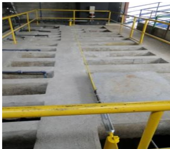
FIGURA 4 - 93: : Instalación de Cerramiento - Proyecto PTAR
