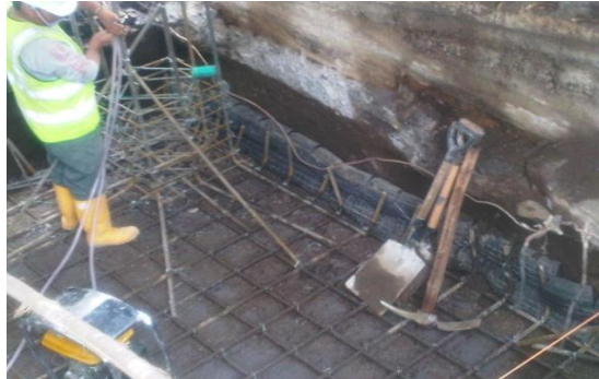
FIGURA 4 - 69: Instalación Mallas a Tierra – Proyecto PTAR
