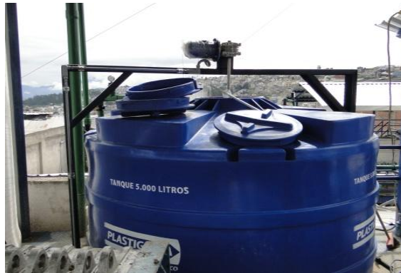
FIGURA 4 - 104: Cambio de moto-reductor - Proyecto PTAR
