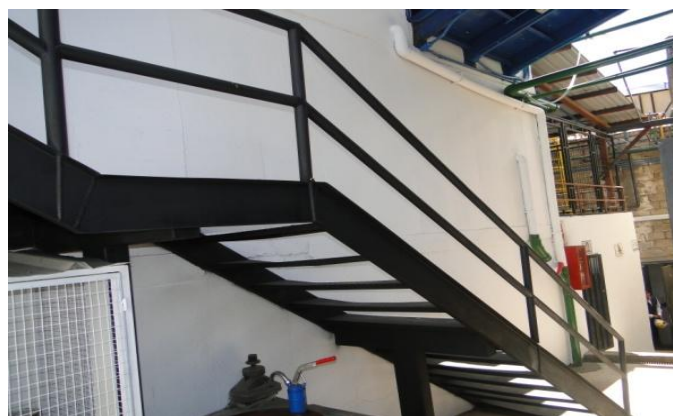
FIGURA 4 - 65: Acceso a PTAR – Proyecto PTAR
