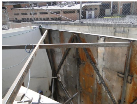
FIGURA 4 - 111: Reconstrucción del Tanque Precipitador - Proyecto PTAR
