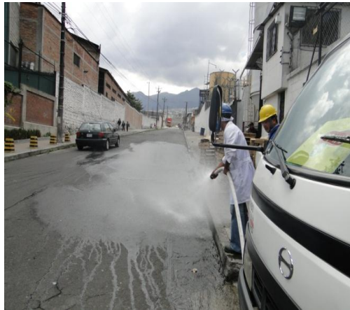
FIGURA 4 - 17: Pruebas de Presión – Sistema contra incendios
