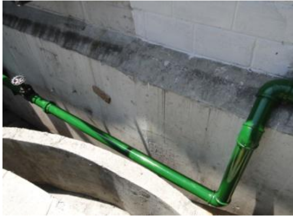
FIGURA 4 - 100: Cambio de tubería - Proyecto PTAR
