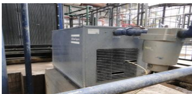
FIGURA 4 - 67: Traslado de líneas y cableado – Proyecto PTAR
