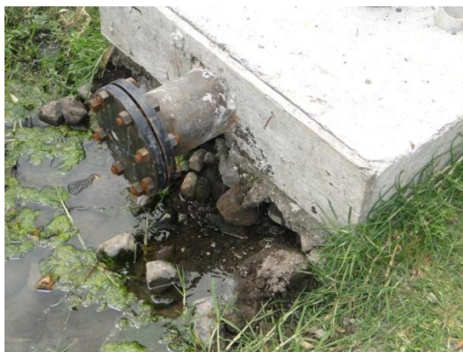
FIGURA 4 - 7: Instalación de bridas
