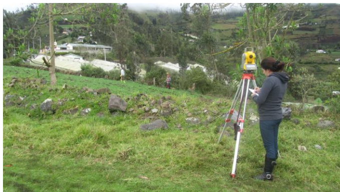
Ramal # 1 de la red de alcantarillado sanitario
