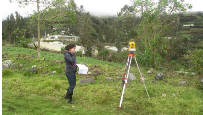
Ramal # 1 de la red de alcantarillado sanitario
