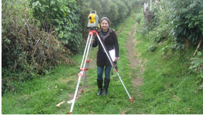
Ramal # 7 de la red de alcantarillado sanitario
