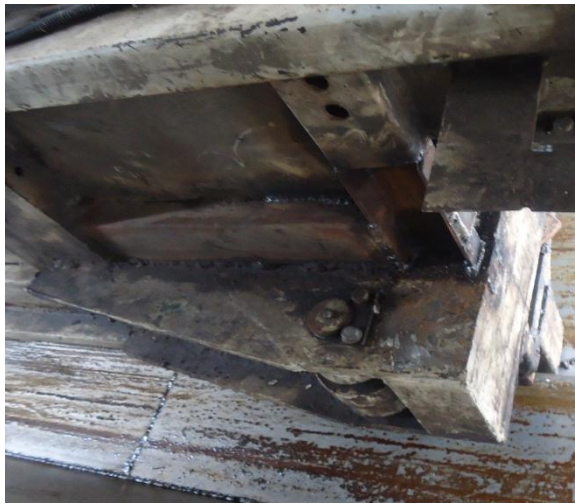
Disposición de juntas soldadas en los apoyos inferiores del pin de sujeción
