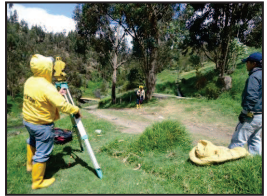
Trabajos de Topografía
