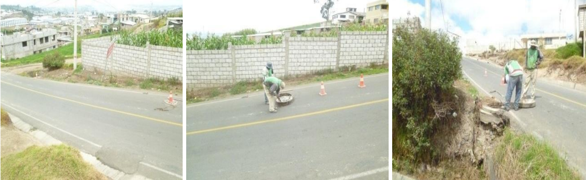
Ubicación de los pozos en la via principal Unamuncho - Samanga
