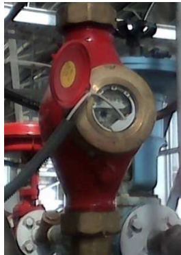
Ilustración 66: Contador de Litros Omega Tipo FTB8020HW.
