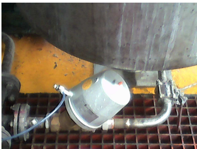
Ilustración 117: Instalación de Válvula de Transferencia de Químicos.
