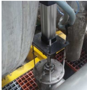
Ilustración 75: Instalación de la Válvula de Cierre de Control de Accionamiento Neumático.
