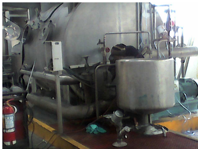
Ilustración 115: Instalación de Válvula de Ingreso de Agua.
