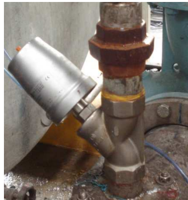
Ilustración 65: Válvula Todo-Nada con Actuador de Pistón y Accionamiento Neumático Spirax Sarco Modelo DN50 PF61G -2NC.
