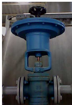
Ilustración 62: Válvula de Regulación de Accionamiento Neumático para Agua MAIT Modelo 21232.
