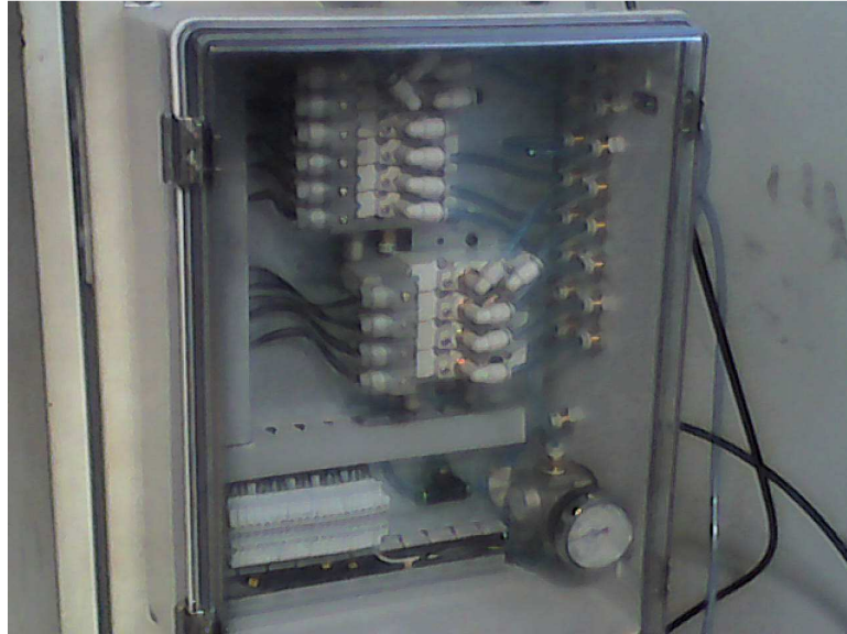
Ilustración 128: Instalación de Tablero Neumático.
