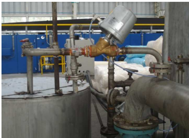
Ilustración 83: Válvula Todo-Nada con Actuador de Pistón y Accionamiento Neumático para Ingreso del Agua de Recirculado a Cuba Spirax Sarco Modelo DN40 PF61G -2NC.
