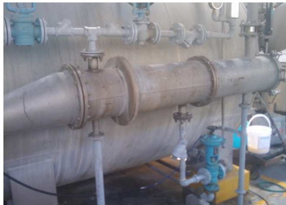
Ilustración 64: Intercambiador de Calor de Casco y Tubos de Flujo Paralelo.
