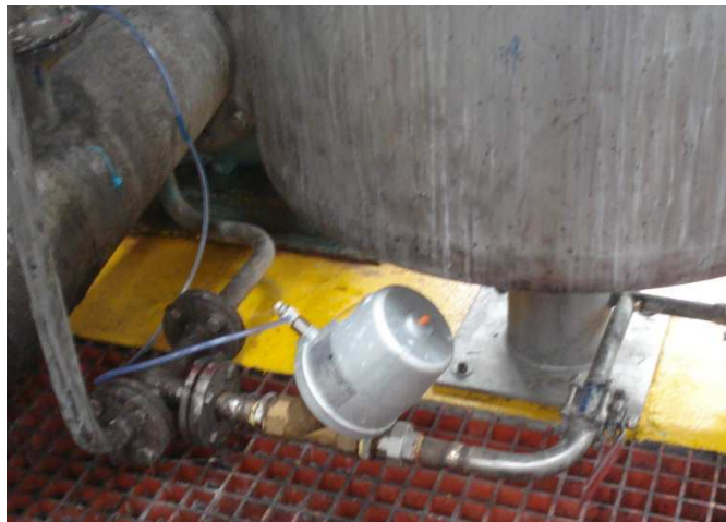
Ilustración 84: Válvula Todo-Nada con Actuador de Pistón y Accionamiento Neumático Ingreso Químicos a Máquina. Spirax Sarco Modelo DN40 PF61G -2NC.
