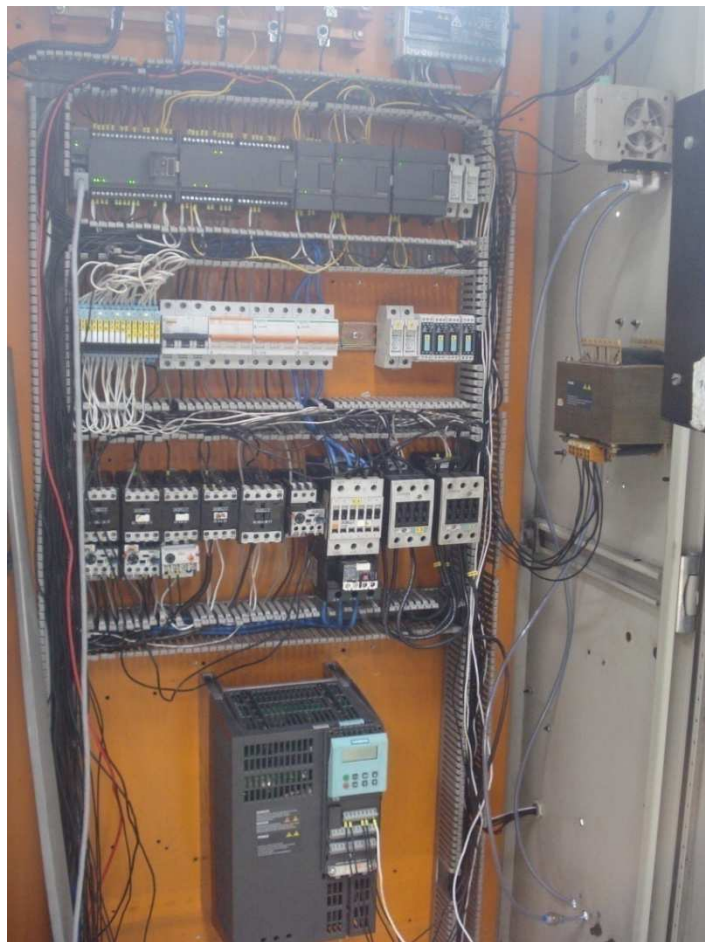
Ilustración 127: Instalación de Tablero Eléctrico.
