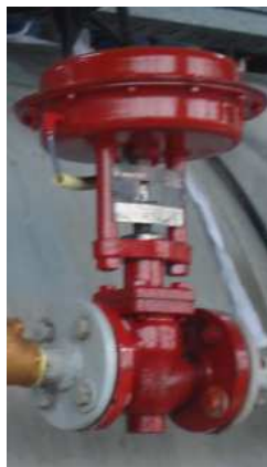
Ilustración 61: Válvula de Regulación de Accionamiento Neumático para Vapor SAFOR MODELO MA25P.
