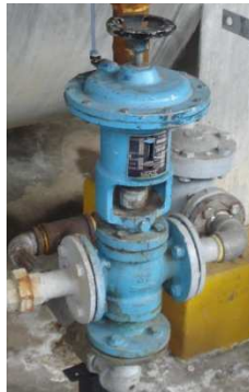
Ilustración 63: Válvula de Tres Vías de Accionamiento Neumático para Vapor Spirax Sarco Modelo QL73D.
