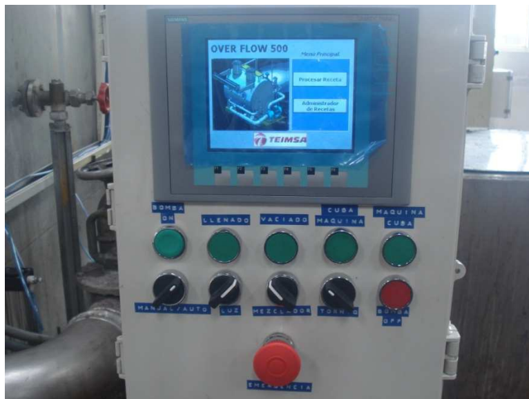
Ilustración 125: Instalación de Tablero de Operación.
