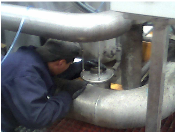
Ilustración 116: Instalación de Válvula de Descarga de Agua.
