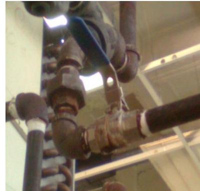
Fotografía No. 14: Desgaste y óxido en tuberías para suministro de vapor de las máquinas.
