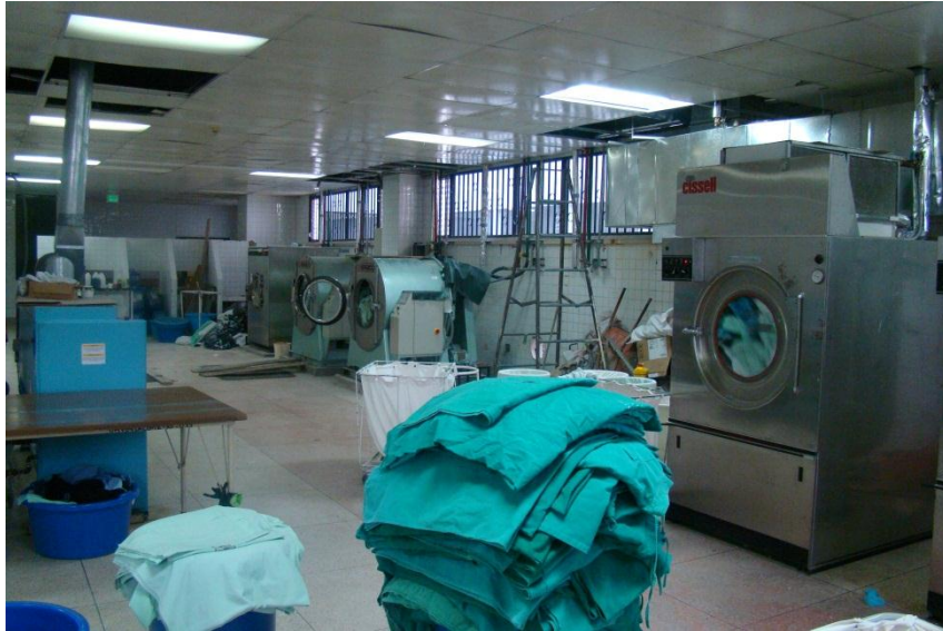
Fotografía No. 3: Acumulación de material.
