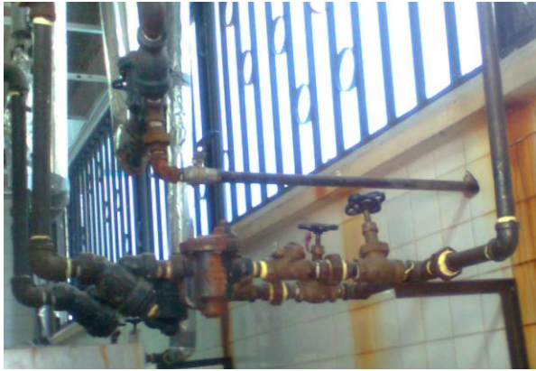
Fotografía No. 14: Desgaste y óxido en tuberías para suministro de vapor de las máquinas.
