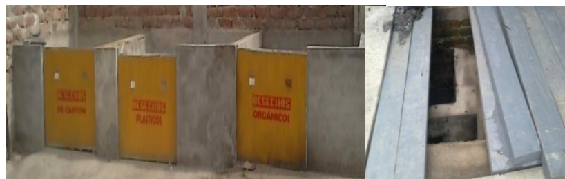
Figura N°42: Área de reciclaje y tratamiento de aguas residuales Fuente: Curtiduría Hidalgo
