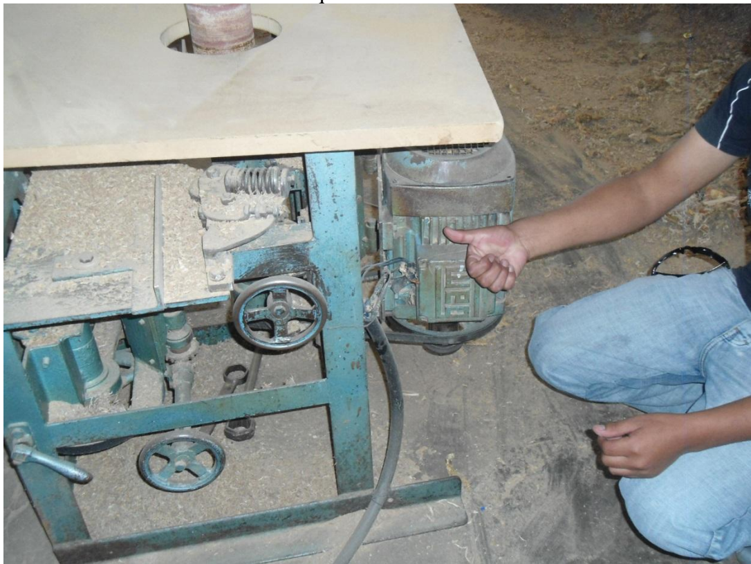
Inspección de las instalaciones eléctricas
