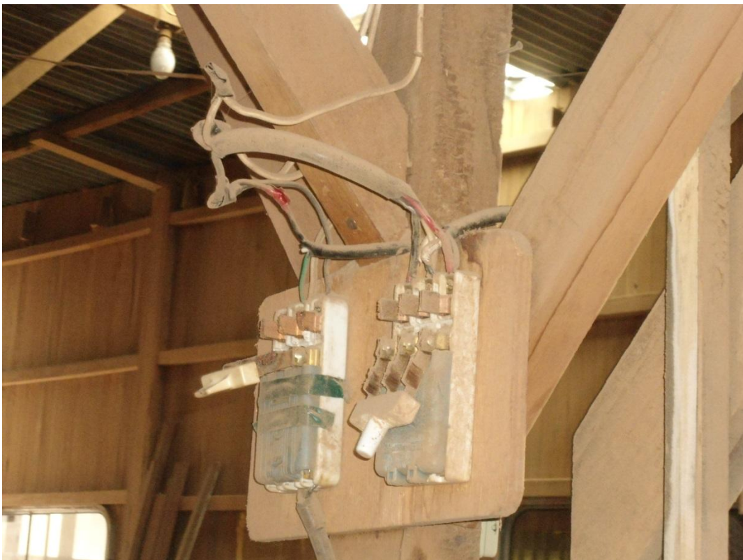
Inspección de las instalaciones eléctricas
