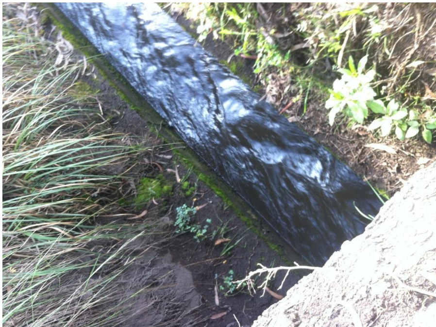
Canal existente en el tramo 9 entre el pozo #55 al pozo #89.
