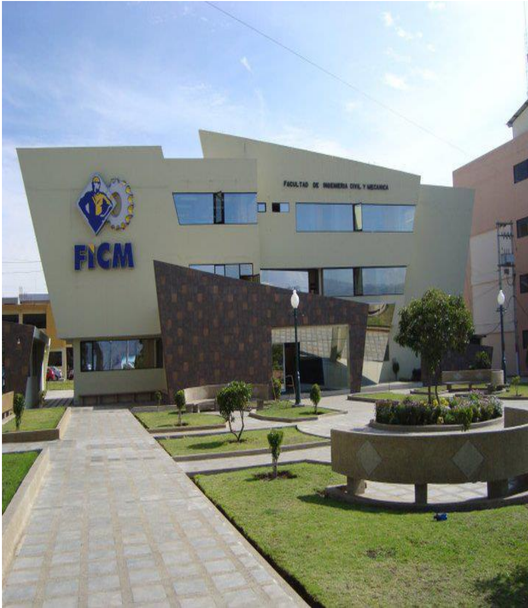
Edificio de la Facultad de Ingeniería Civil y Mecánica.
