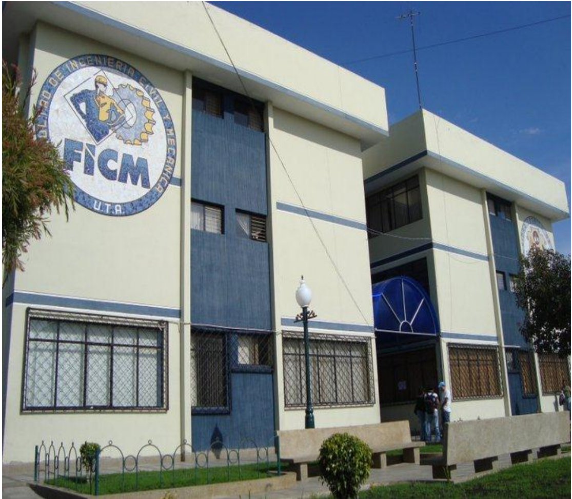
Edificio de la Facultad de Ingeniería Civil y Mecánica.
