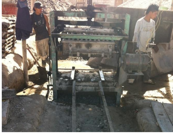
Imagen N°23.- Máquina de vibro-compactación
