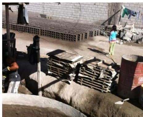
Imagen N°27.- Curado en las bloqueras con regado de agua
