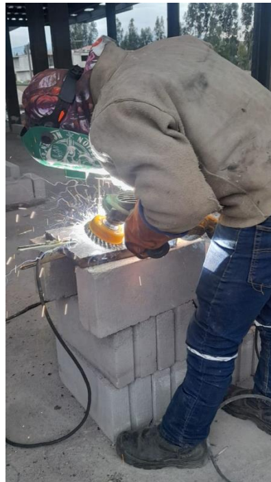
Figura 11. Grata metálica para limpieza de superficie
