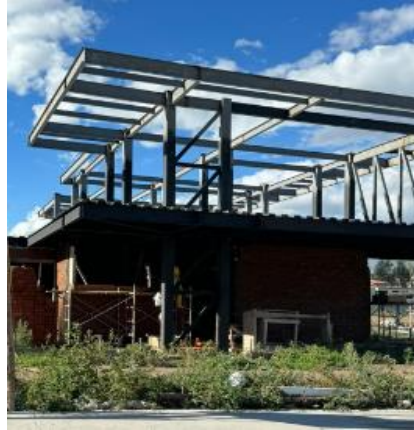
Figura 4. Construcción en acero estructural
