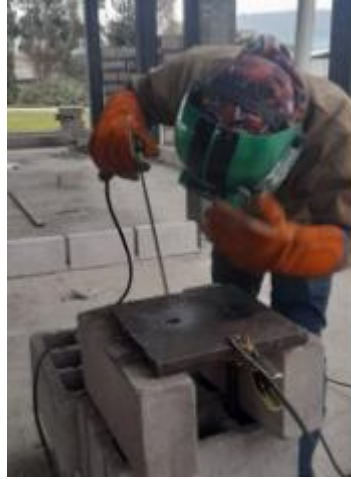
Figura 14. Soldadura SMAW en la placa base-varilla
