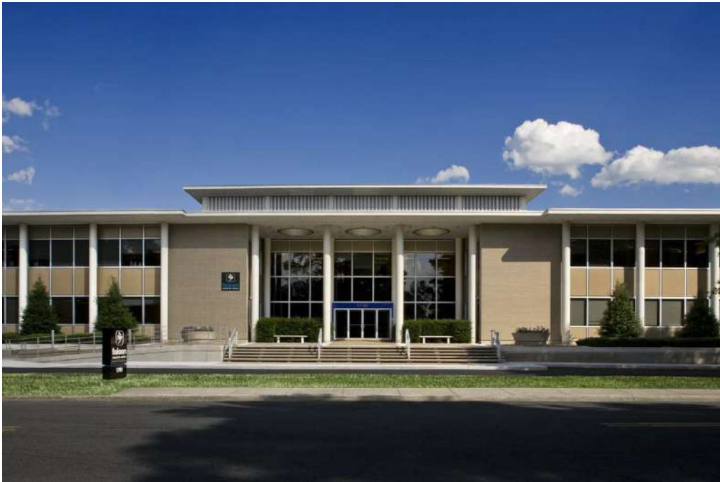
Figura 40. Fachada frontal de la Escuela Faison
