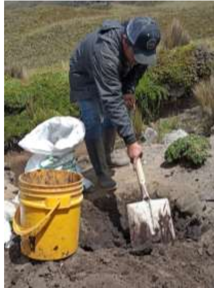
Figura N° 14. Calicata N° 2 - subrasante
