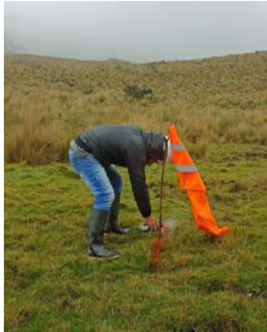
Figura N° 11. Colocación del último punto de control en la abscisa 12+000
