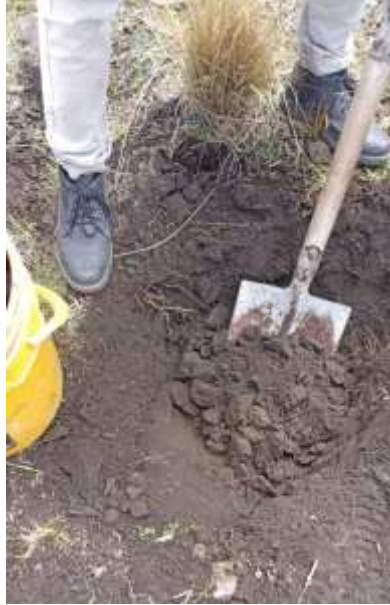
Eliminación de capa vegetal
