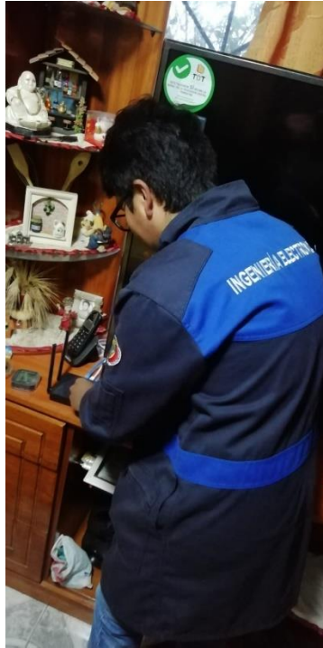
Figura G2. Conexión de las cámaras con el router TP Link
