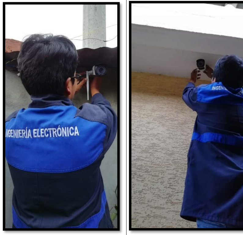
Figura 22. Instalación de las cámaras
