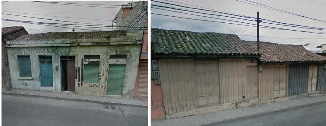
Figura 44. Problemática de rehabilitación y restauración de viviendas patrimoniales
