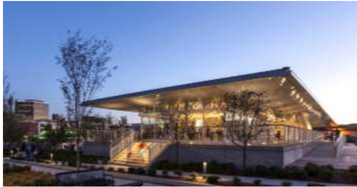
Figura 12. Vista al Centro comunitario. (SWA Group, 2015)
