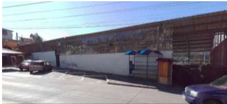
Figura 55. Cubierta Subutilizada. Autoría propia 2023
